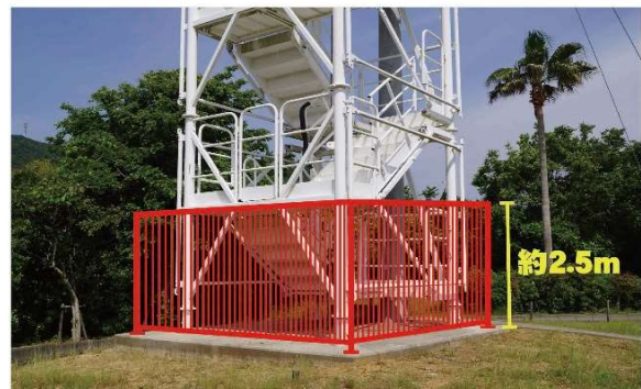
基礎部分に合わせてタワーを囲い足元はアンカーで固定
